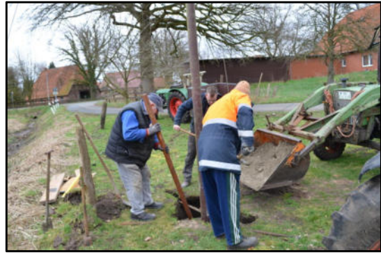
Einbetonieren des Standrohres
