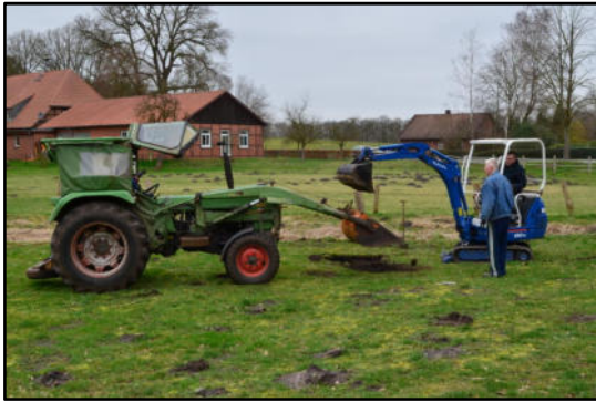
Erdaushub für Standrohr
