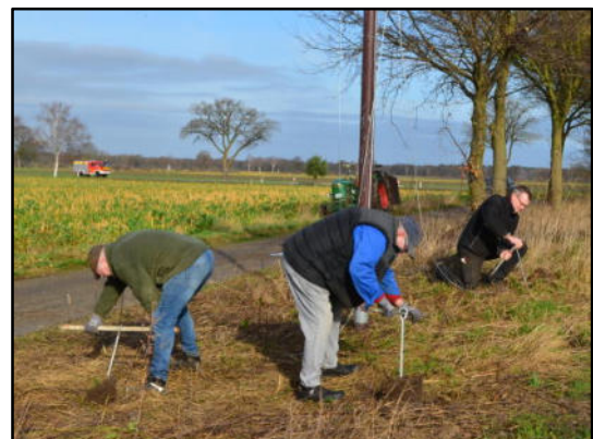
Setzen der Abspann-Bodenanker (Febr. 2020)
